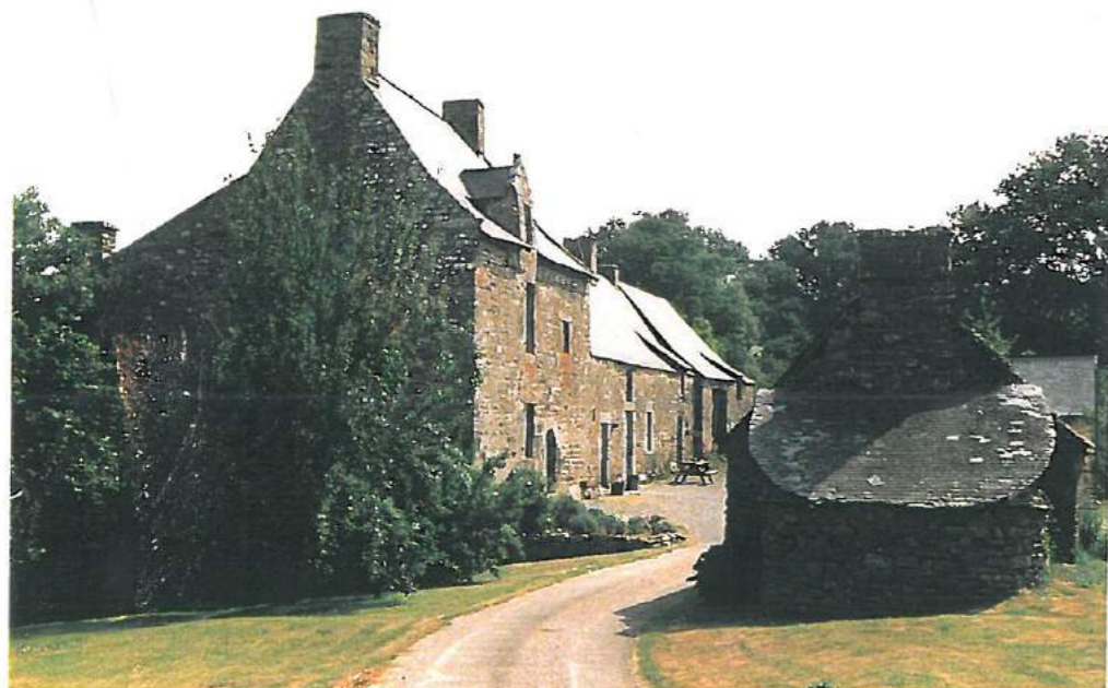
Façade Sud bâtiment ① et four ②
