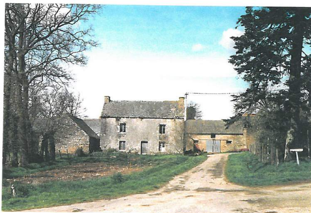
Façade Sud bâtiment ②
