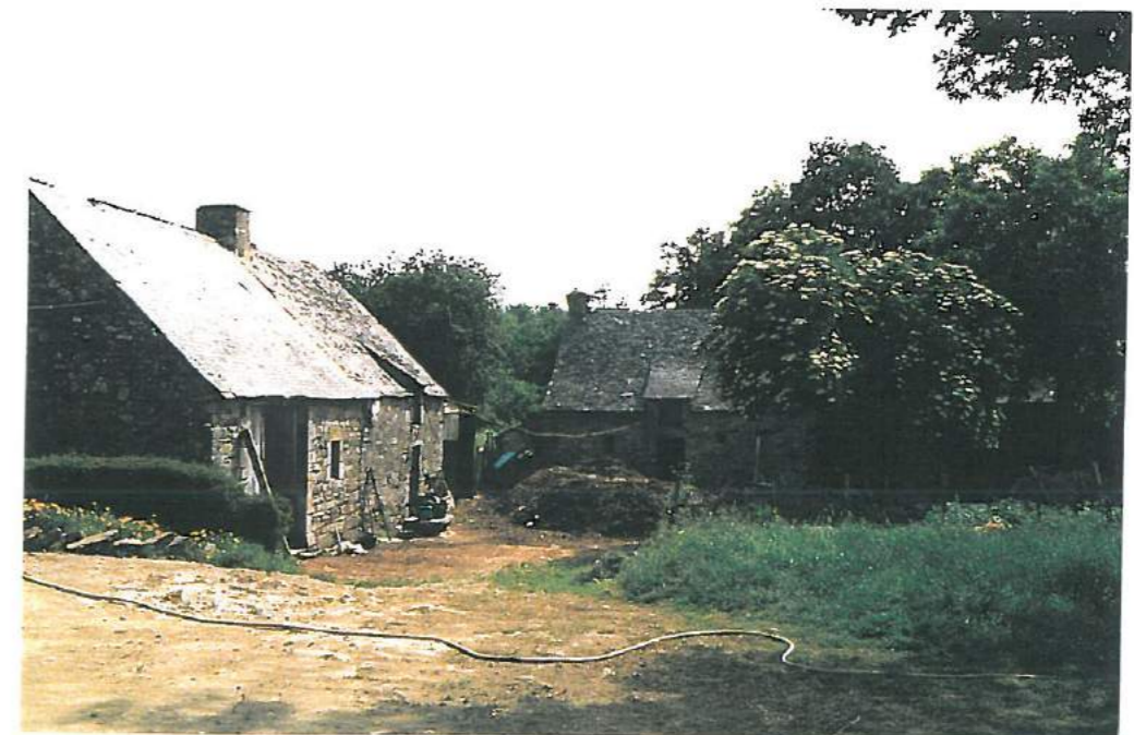
Façade Sud et Ouest bâtiment 1
