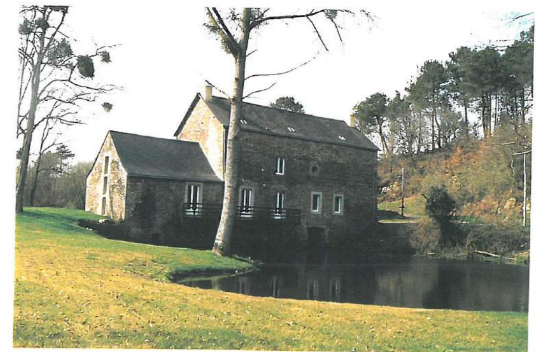
Façade Est bâtiment ②
