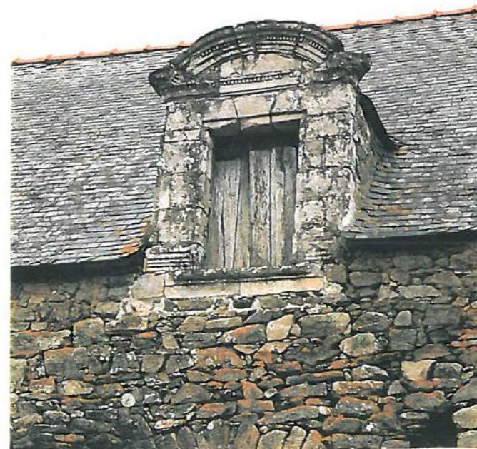
Lucarne grange (bâtiment ②)
