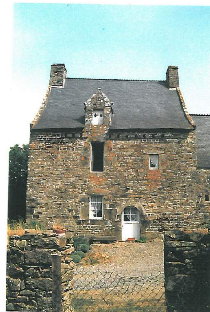
Façade Sud bâtiment ①
