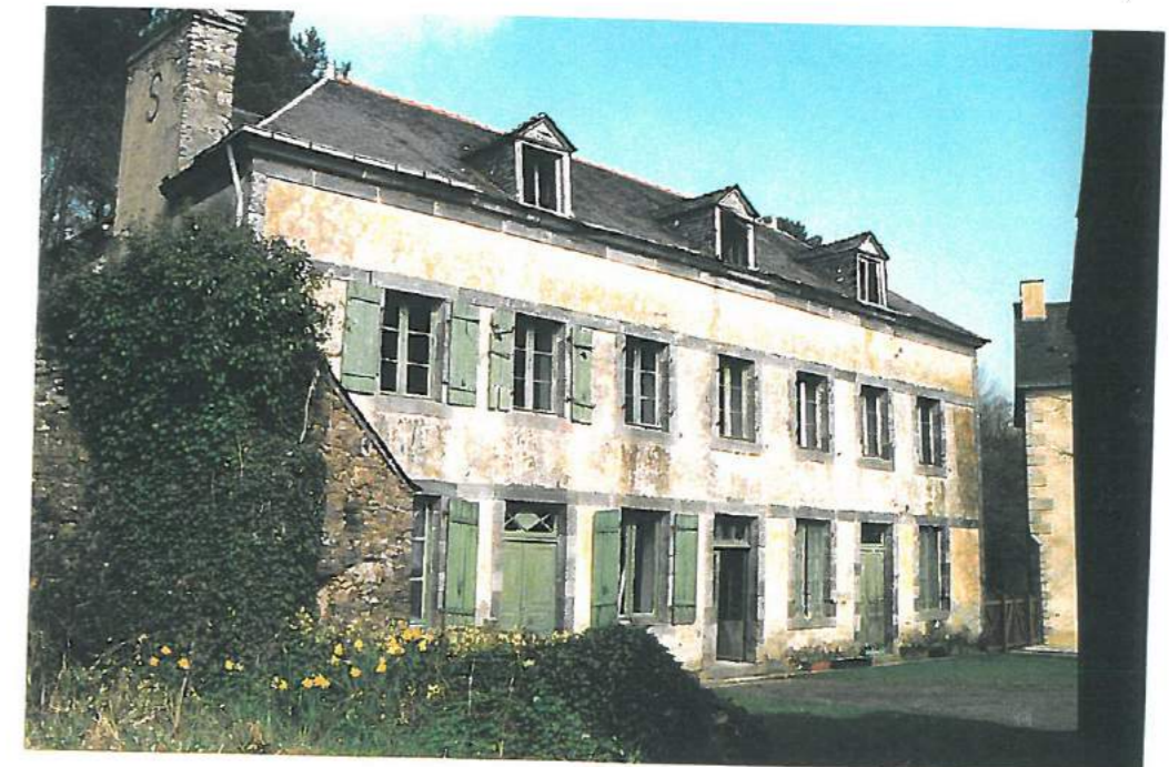
Façade Sud bâtiment ①
