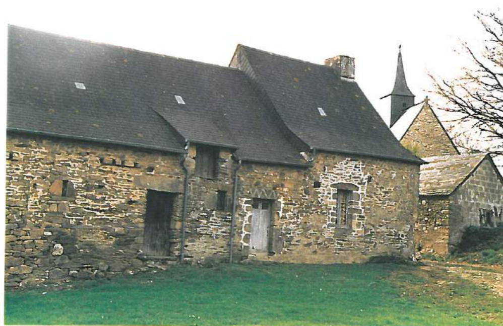
Façade ouest bâtiment ② et pignon bâtiment ④
