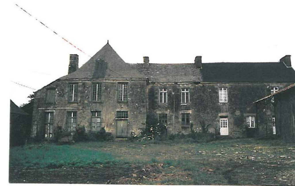
Façade Sud bâtiment ①
