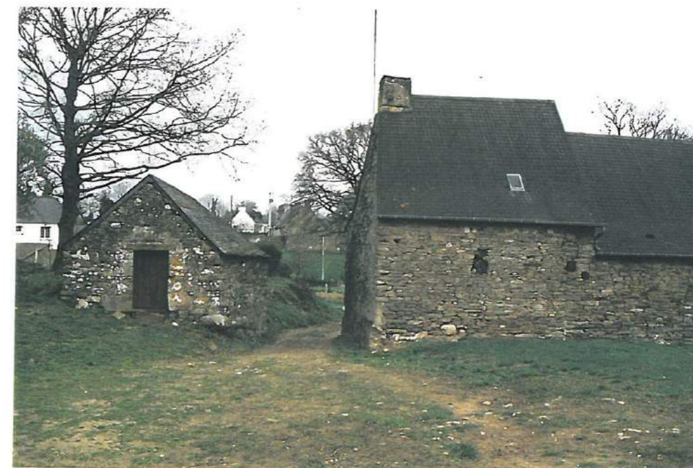
Façade Est bâtiment ② - Pignon Est bâtiment ④
