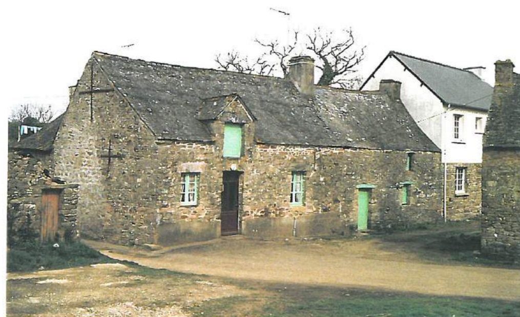
Façade Sud/Ouest bâtiment
