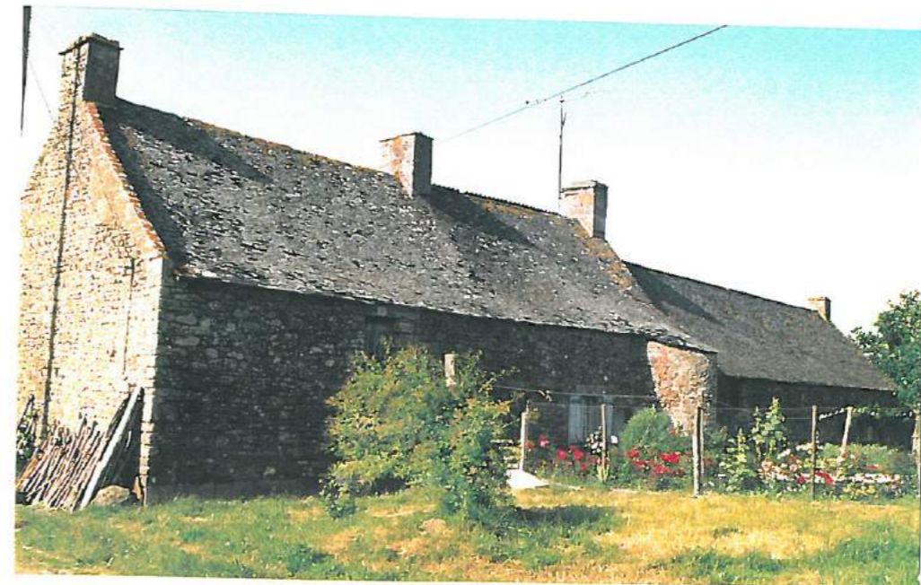
Façade Sud bâtiment ①
