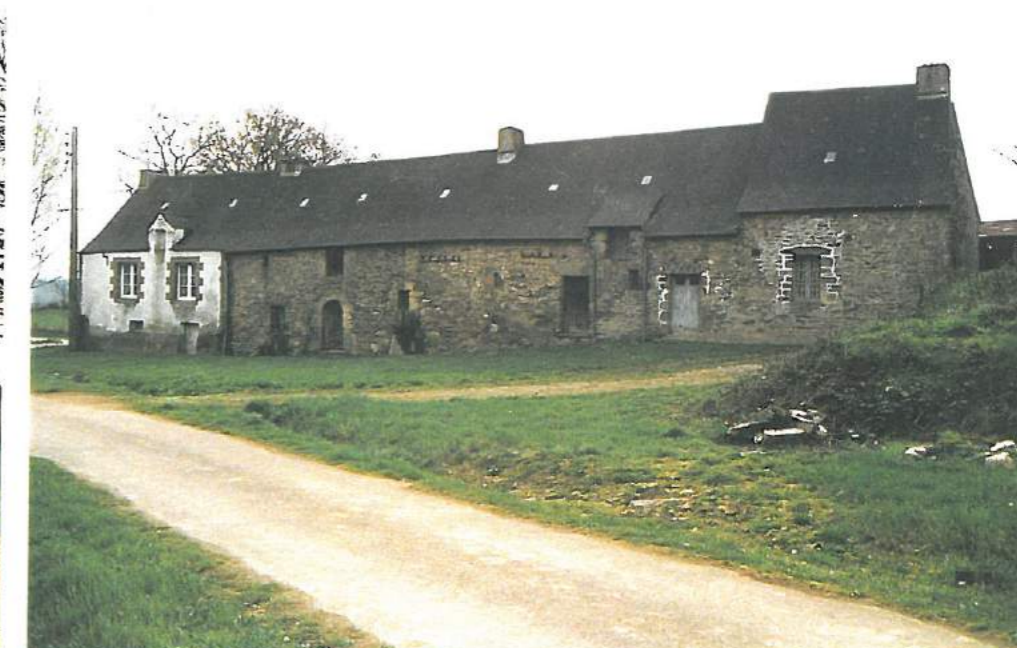
Façade Est bâtiment ②
