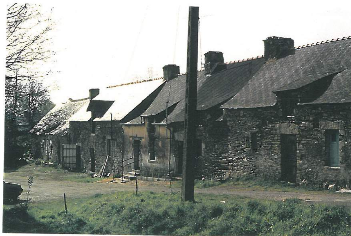
Façade Sud longère (côté Ouest)
