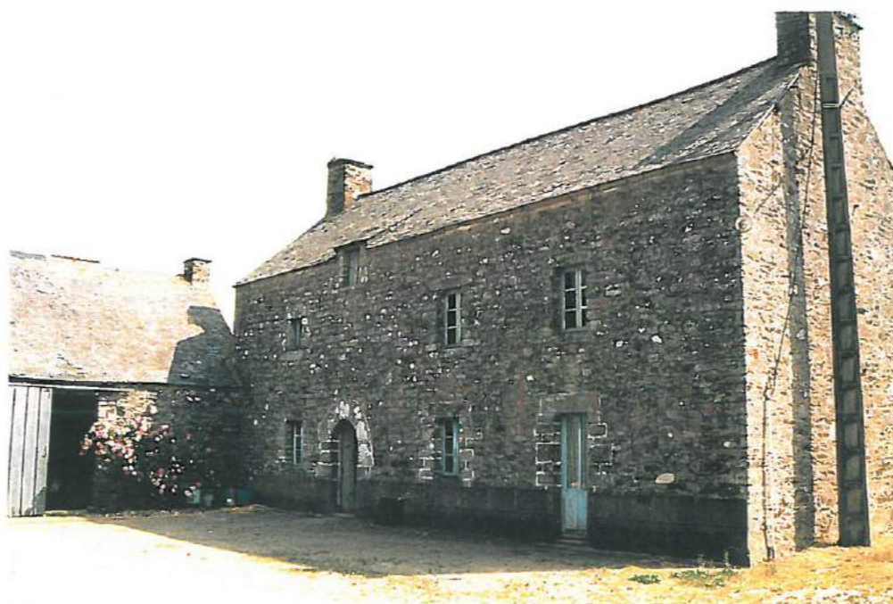
Façade Ouest bâtiment 1
