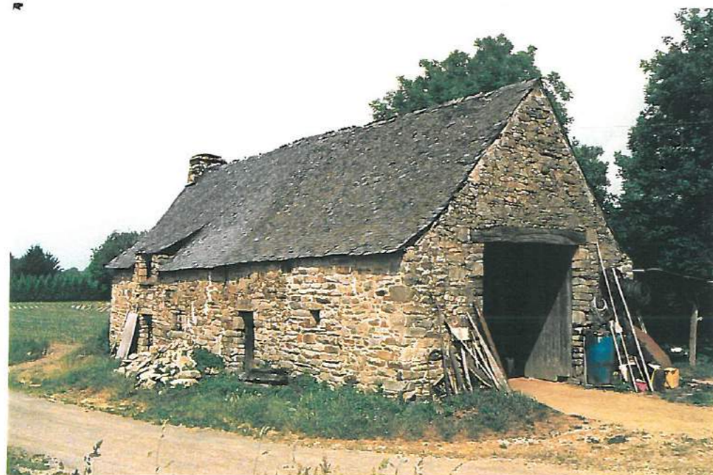
Façade Sud pignon Est bâtiment 3
