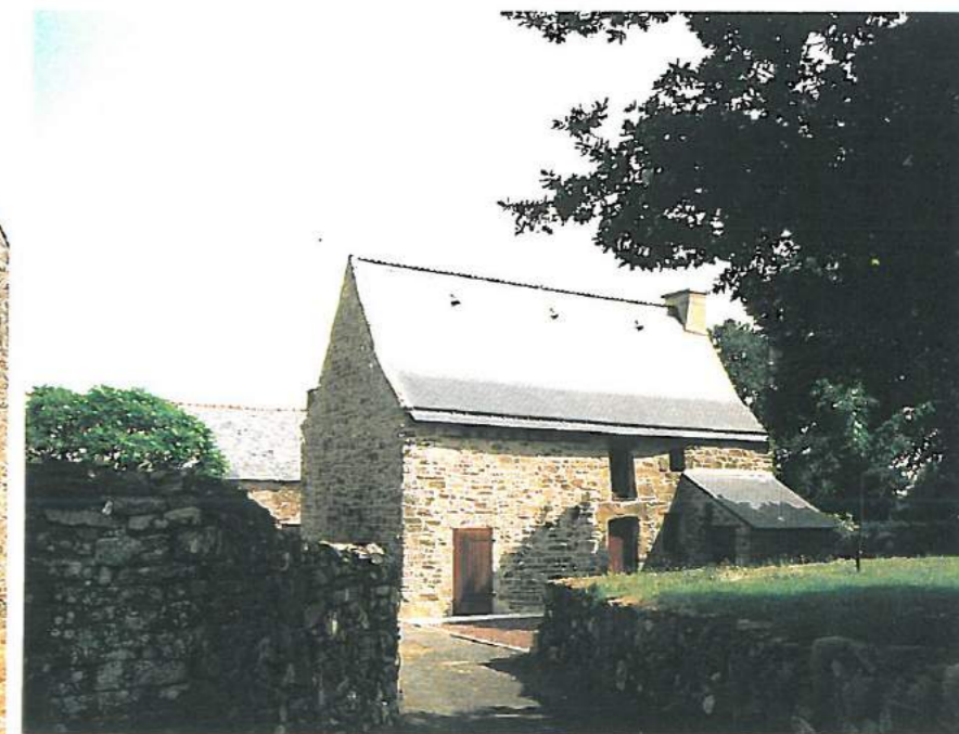
Façade Sud bâtiment 3
