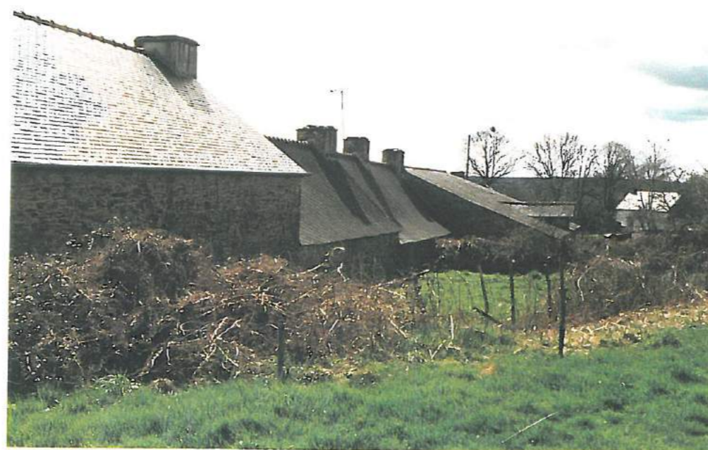
Façade Nord longère
