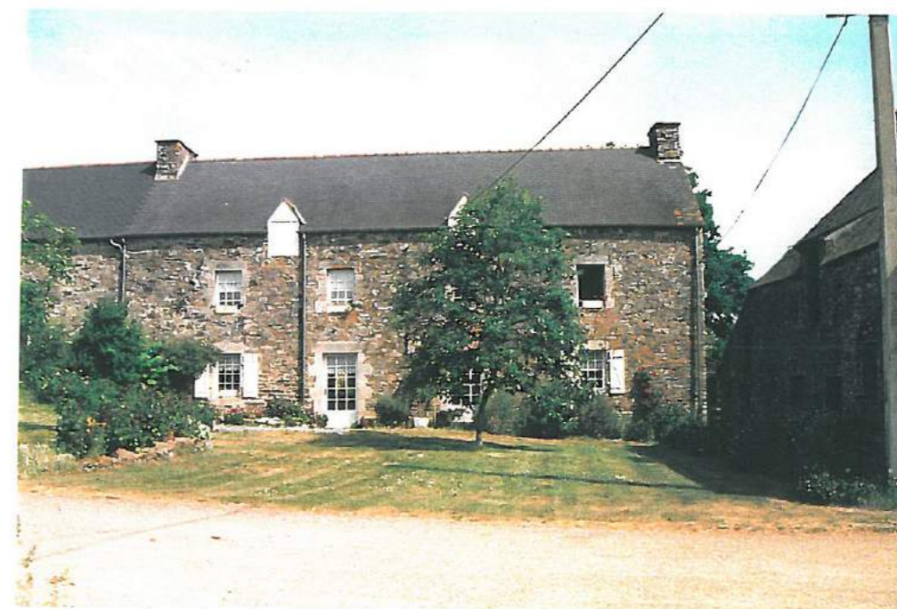
Façade Sud bâtiment ③
