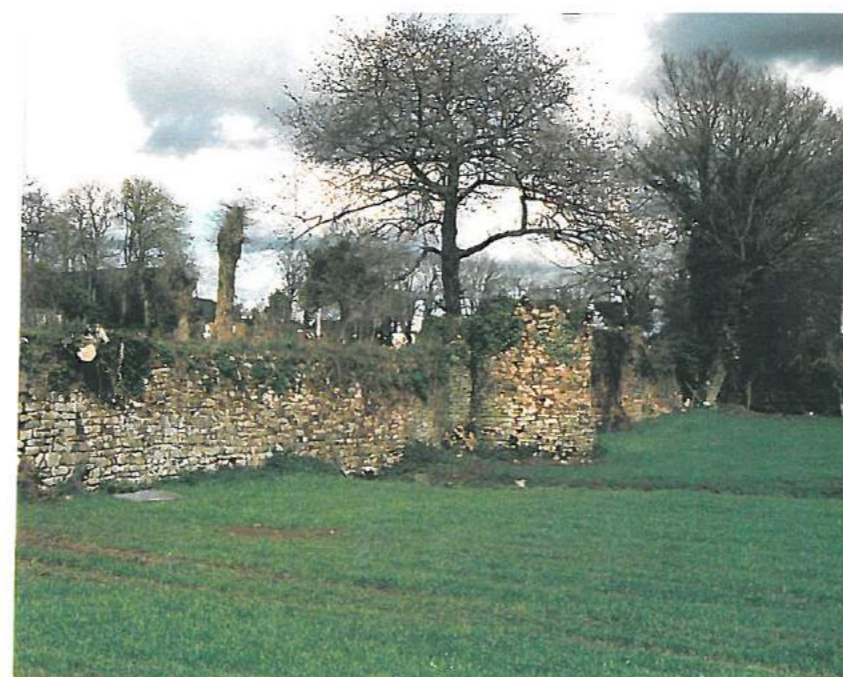
Mur de soutènement de la terrasse au Sud
